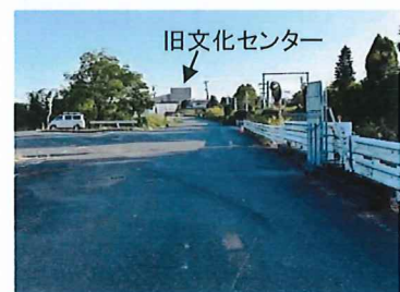
終点側から撮影 (旧文化センター方向を望む)
