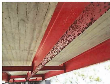
主桁の腐食
