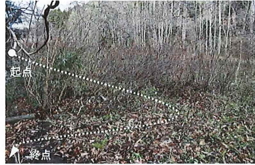
橋梁地点から路線起点方向を撮影 植生が繁茂し進入困難
