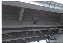
ドローンによる桁下の点検
