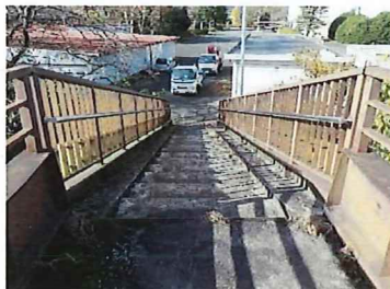
橋梁起点(旧町役場)方向
