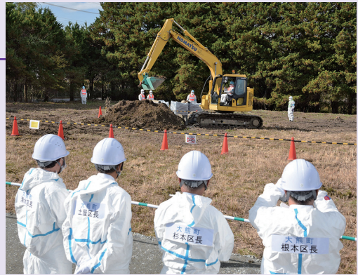
関係者が見守る中で始まった工事
