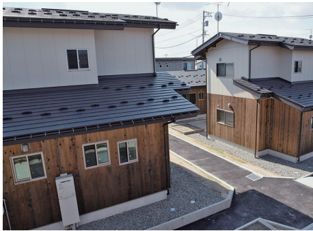
完成した白虎団地
