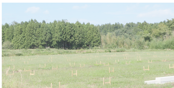
▲設置位置に木杭が打ち込まれていました。一面がソーラーパネルになると想像すると圧巻です
